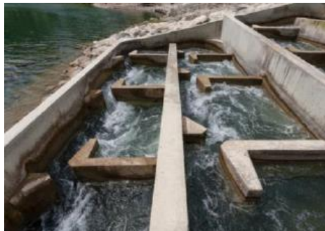
Passe à simples fentes verticales (© pôle écohydraulique, OFB)
