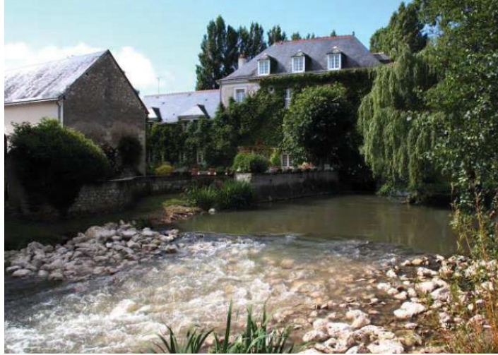
Arasement partiel du seuil d'un moulin (© M. Bramard, OFB)
