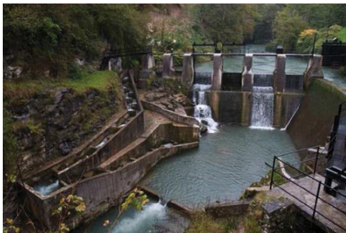
Ouvrage équipé d'une passe à bassins successifs (© S. Richard, OFB)
