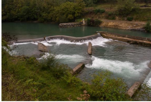
Exemple de pré-barrages (@ pôle écohydraulique, OFB)
