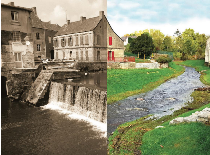
Avant/après le dérasement du seuil Pasteur sur la commune d'Hirson (©EPTB entente Oise-Aisne et Agence de l'Eau Seine Normandie)
