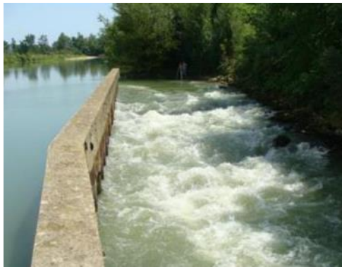
Rampe rugueuse (© M. Chanseau, OFB)
