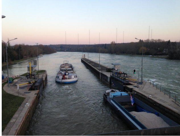
Écluse de navigation (© VNF)
