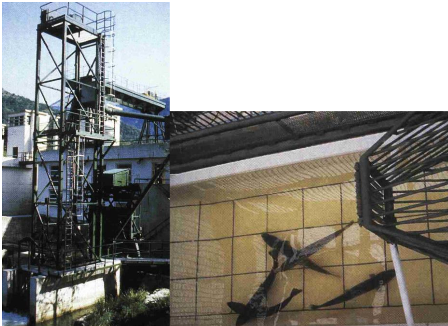
Ascenseur à poissons (gauche) et poissons dans la cuve d'un ascenseur en train de remonter (droite) 90
